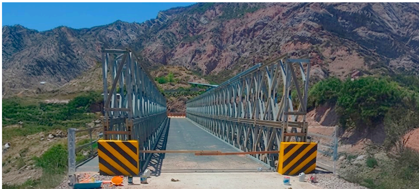
PUENTE MODULAR AYACUCHO
